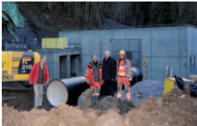
Bürgermeister Rudi Hakel informiert sich vor Ort über den Baufortschritt bei der Errichtung des Kraftwerkshauses, welches voraussichtlich im Februar 2013 die beiden Turbinen aufnehmen wird.
