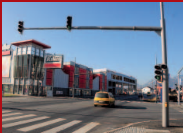
Bei der „KIKA-Kreuzung“ wurde eine zusätzliche Ampelanlage installiert. Bitte beachten Sie bei allen Ampeln an der B 320 die erforderliche „Anmeldung“ an den jeweiligen Haltelinien und Fußgängerampeln.
