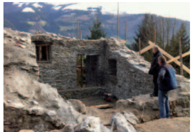
Der Leiter der Bauverwaltung, Ing. Reinhold Kalsberger, und Baumeister Laurentiu Dascalu (im Bildvordergrund) besprechen die Arbeiten zur Erhaltung der Klaus Reithal.
