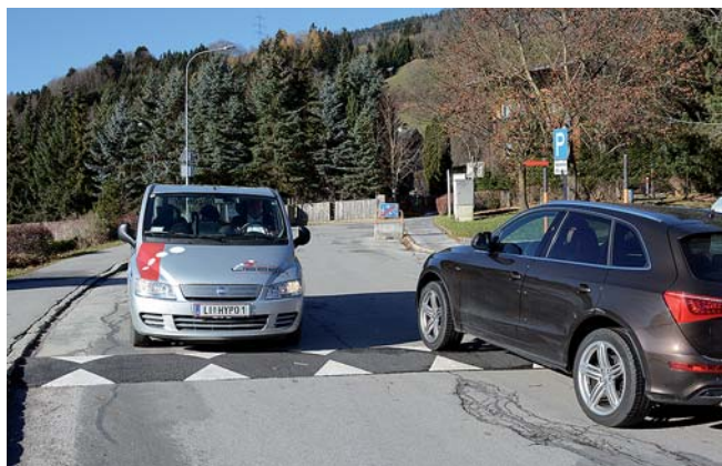
In der als Wohnstraße ausgewiesenen Alpenbadstraße wurden zu den bereits vorhandenen zwei Bodenschwellen zwei weitere Erhebungen asphaltiert und gekennzeichnet. Entsprechend der geltenden Straßenverkehrsordnung ist in Wohnstraßen neben anderen Vorschriften das Befahren nur mit Schrittgeschwindigkeit erlaubt.
