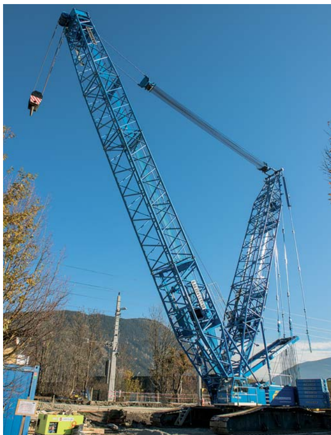
Für den Umbau der Eisenbahnkreuzungen gelangte auch schweres Gerät zum Einsatz.
