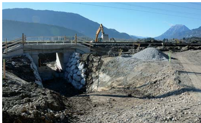
Die Fuß- und Radwegunterführung in Verlängerung der Schillerstraße wird in diesen Tagen ihrer Bestimmung übergeben.
