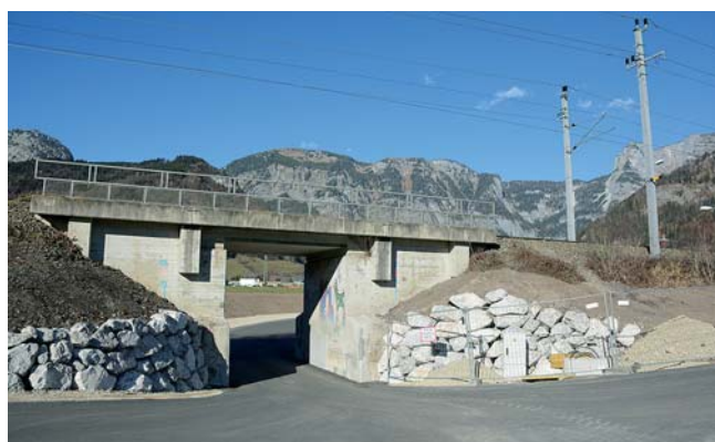
Der Ausbau der Unterführung beim Bauernhof Platzer im Ortsteil Weißenbach ist bereits abgeschlossen.
