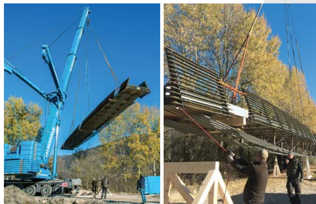
In einem spektakulären Einsatz wurde die Radwegbrücke in einem Stück aus ihrer Verankerung gehoben und für die bevorstehende Reparatur zwischengelagert.
