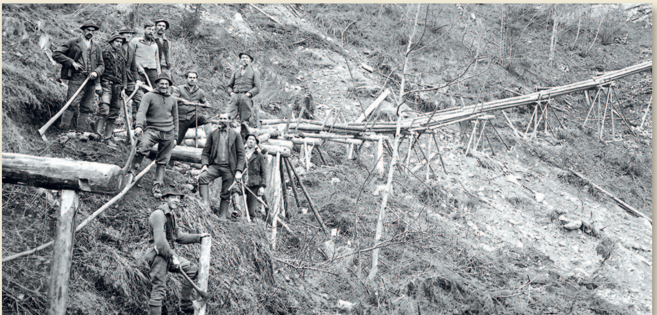
Damals zwar üblich, aber trotzdem eine großartige Leistung: Abtransport des 1936 auf der Schlossalm geschlägerten Holzes über eine eigens dafür erbaute 2,5 km lange Holzriese.
