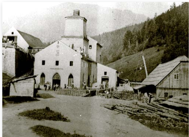
Eines der wertvollen Bilddokumente des aktuellen Vortrages: der ehemalige Hochhofen „Amalienhütte“ im Pyhrn (jetzt Liegenschaft „Amort“).
