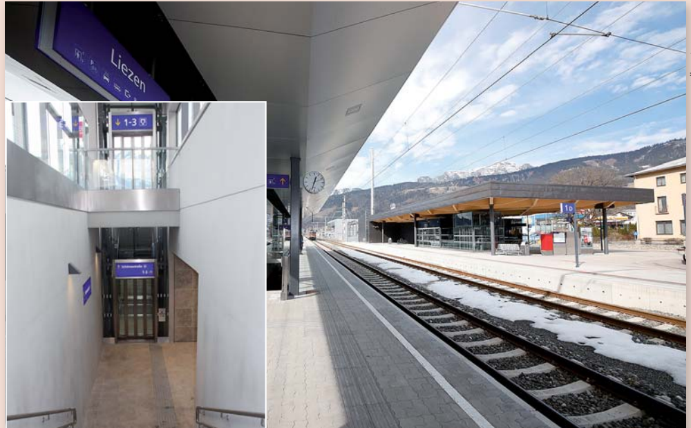
Das neue Gebäude mit Aufzug, dem Abgang zum Personentunnel und einem Bike & Ride Platz mit 48 Stellplätzen, einer WC-Anlage und einem beheizten Wartebereich.
