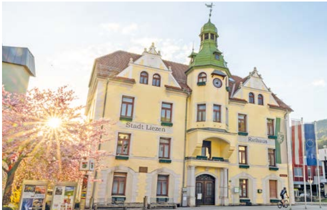
Der neue Eingang in das Rathaus Liezen durch das historische Tor über die Hauptstraße.
